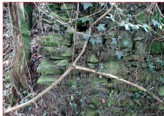
Muret en pierre sèche considéré gîte potentiel à reptiles in situ , Géonomie 2021
